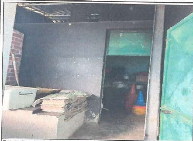
Foto 1: Pared y polleto a remodelar de la cocina.
