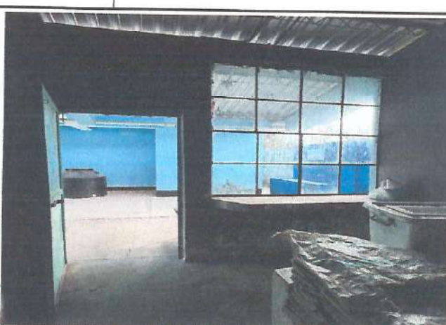
Foto 2: Ventana y puerta a remodelar de la cocina.
