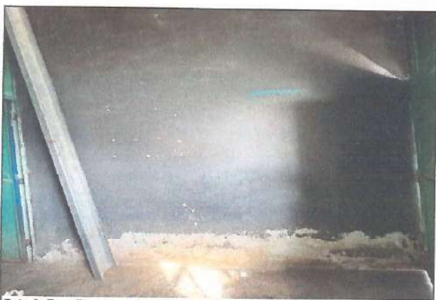
Foto 3: Repello a remodelar de la cocina.
